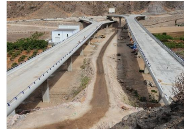
Imagen 2. Viaducto de Mogán
