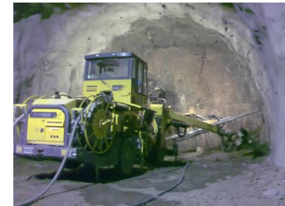
Imagen 3. Trabajos de perforación Taurito
