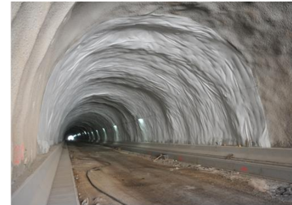
Imagen 5. Impermeabilización Túnel Mogán
