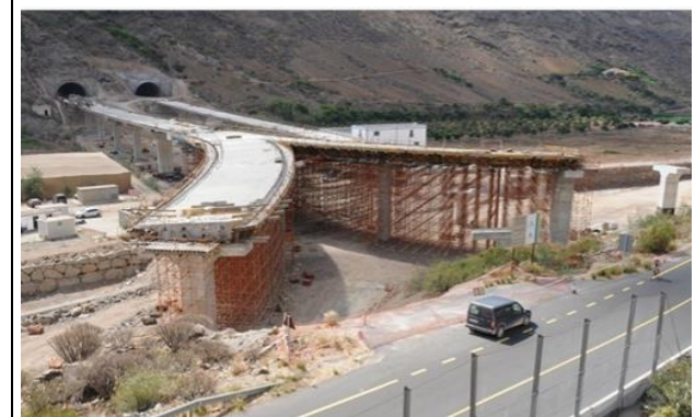
Imagen 9. Cimbra Cuajada Viaducto de Mogán
