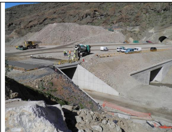
Imagen 15. Ejecución de Pasos Inferiores
