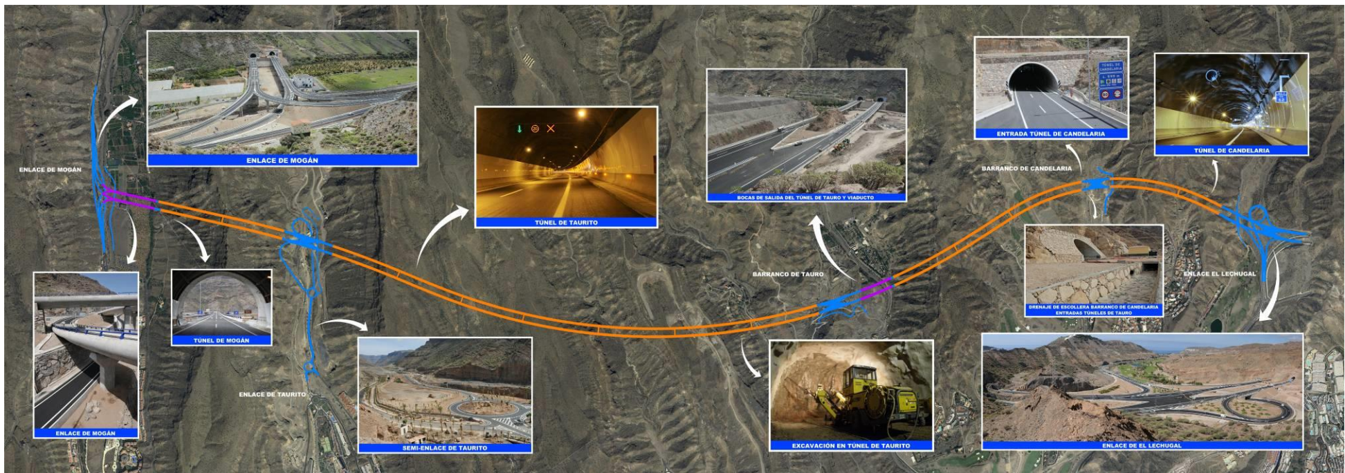
Imagen 17. Estado definitivo de las obras
