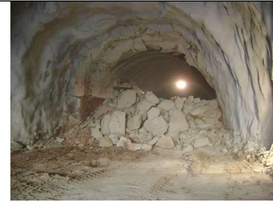
Imagen 4. Cale Túnel Candelaria
