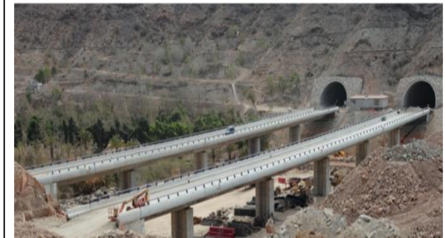
Imagen 3. Viaducto de Tauro
