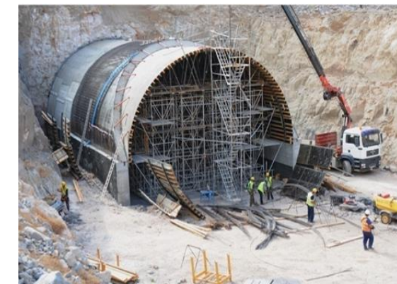
Imagen 6. Cimbra en Falso Túnel de Tauro
