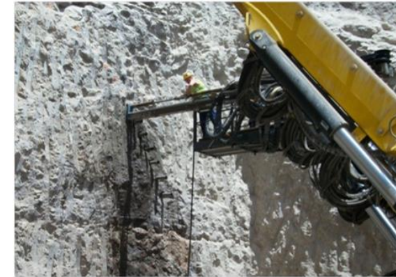
Imagen 2. Emboquille túnel de Candelaria
