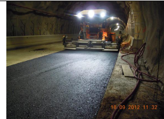
Imagen 7. Asfaltado en interior de Túnel
